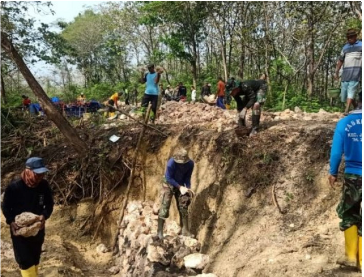
Anggota Satgas TMMD Reguler ke-113 Kodim 0721/Blora gotong royong membangun talud di Desa Pengkoljagong Kecamatan Jati
